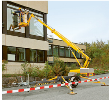
3 Hubarbeitsbühnen bei unzugänglichen Fassaden
